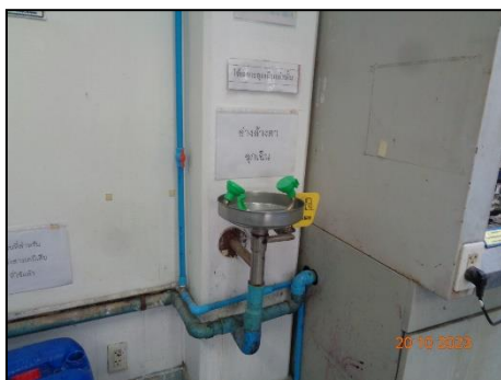
ภาพที่ 2.2-26 ฟักบัวฉุกเฉินและที่ล้างตา
