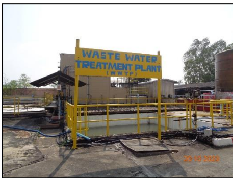
ภาพที่ 2.2-13 บ่อพักน้ำทิ้งฉุกเฉิน
